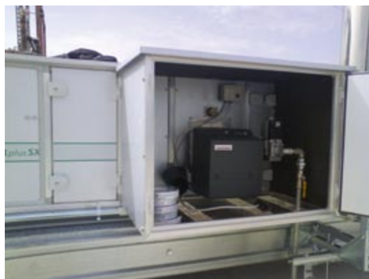
Voorbeeldmontage van een Weishaupt brander in een CAIRplus luchtgroep
